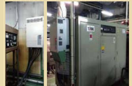
亀岡工場では、75kw相当のエンジンコンプレッサーを自社改造し、構築したPLCネットワークに接続して、電力ピーク時に自動でエンジン始動、工場圧縮エア配管との接続、エア供給、エンジン出力調整、デマンド低下でエンジン停止が出来るシステム開発に成功。
