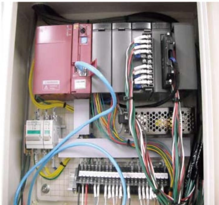
空調、照明、冷凍冷蔵設備を ICT 技術（情報通信技術）により効果的に制御しながら、その運用状況、エネルギーの使用状況を外部サーバーに記録。収集したデータを基に設備の運用を見直し、無駄なエネルギーの削減を図る。
