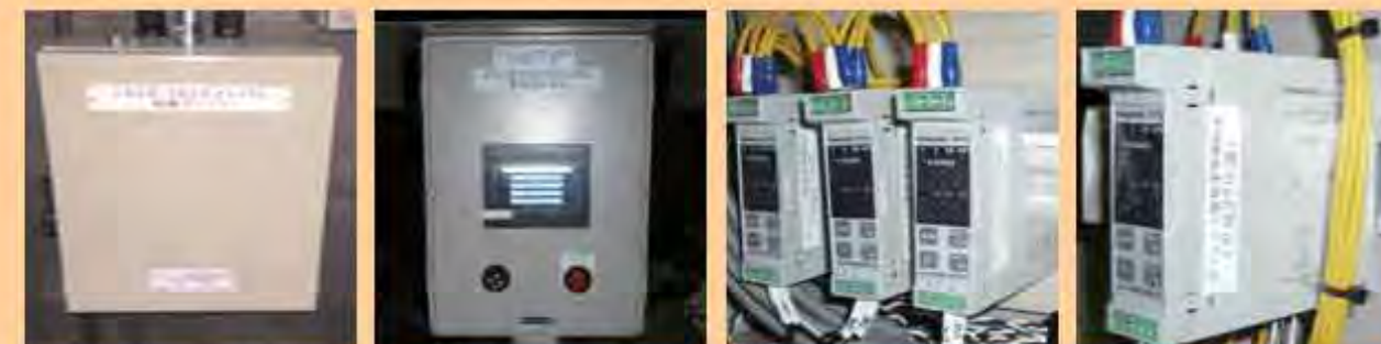
電力見える化システム 制御ボックス 電力見える化システム 表示ボックス 小型電力計 1) (2) (3) 小型電力計 4)
