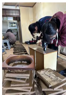
改修作業の様子
